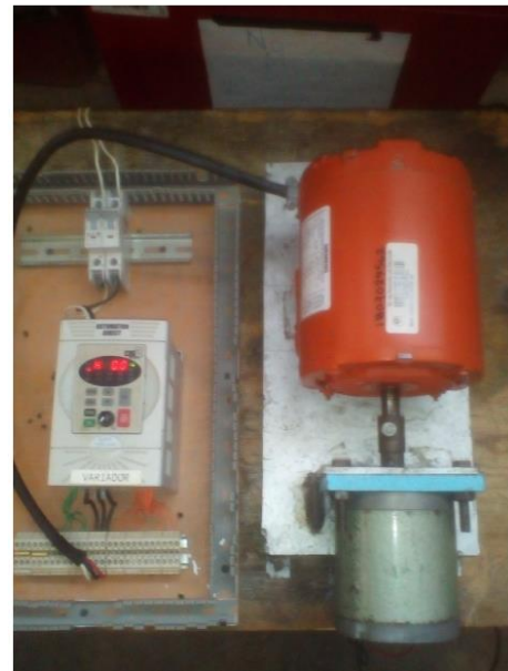
Figura 11 Motor trifásico y generador
