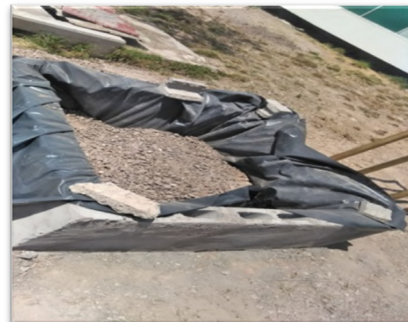
Figura 1. Elaboración del Humedal y colocación de sustratos
